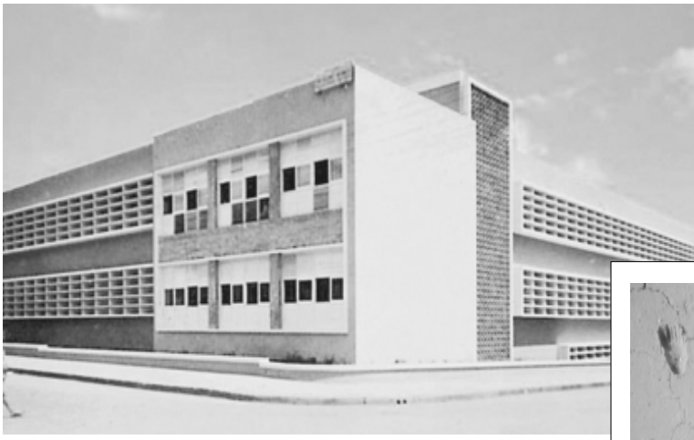
El otrora edificio del Instituto Nacional Central Miguel Ramírez Goyena, uno de los principales Templo de enseñanza de Managua.
