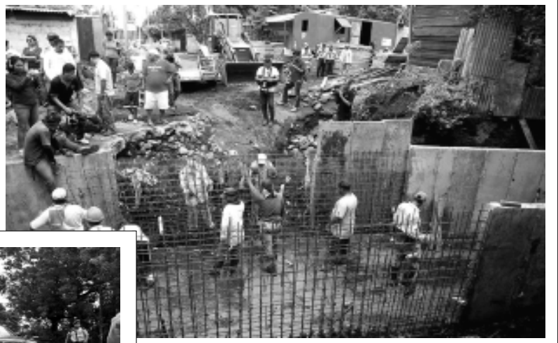
Hasta que llovió medio fuerte, las autoridades de la Alcaldía corrieron a instalar diques, a ver si contenían las aguas.
